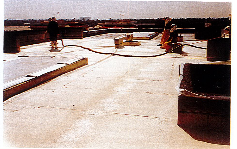
وضع المواد العازلة لحماية الأسطح
