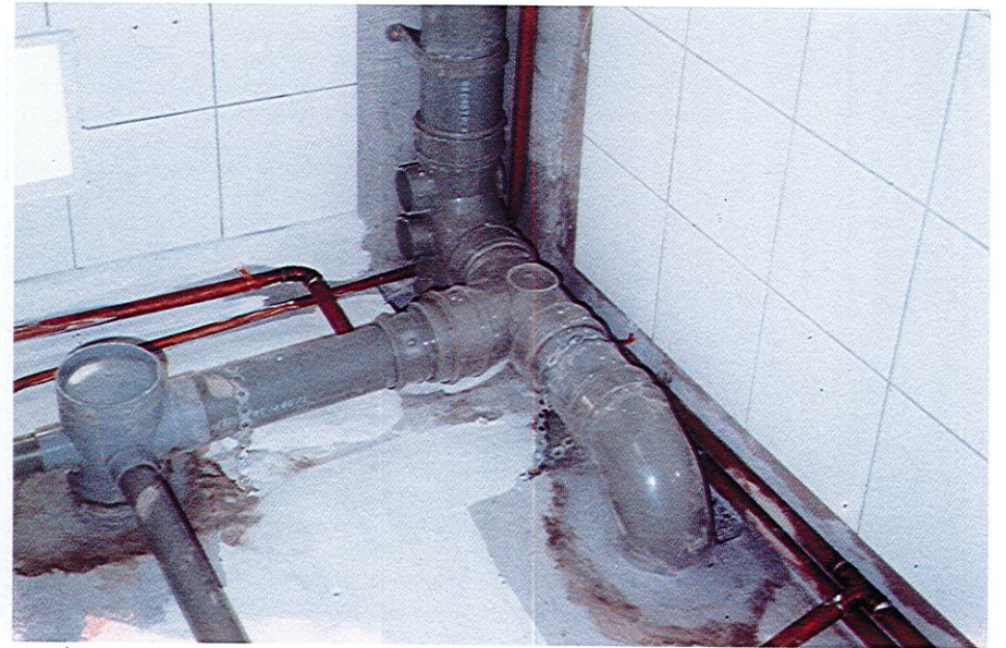
تركيب تمديدات الأعمال الصحية والتزويد بالمياه الباردة والساخنة
