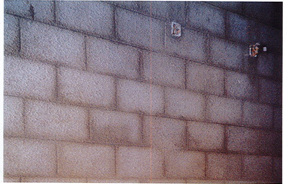
أعمال المساح إبتداء بالطرطشة
