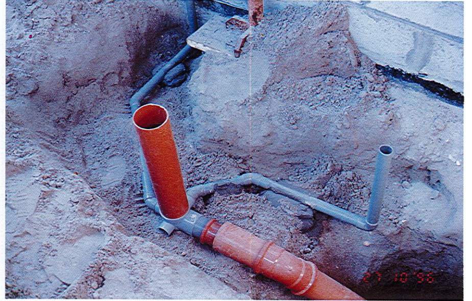
وضع أنابيب الصرف الصحي
