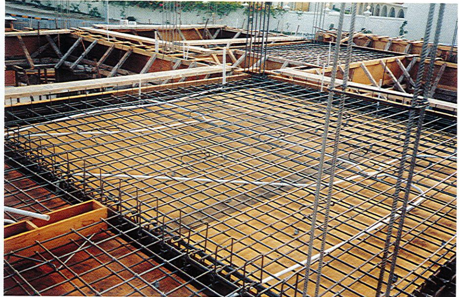
وضع حديد تسليح بلاطات الحمامات في الطوابق العليا
