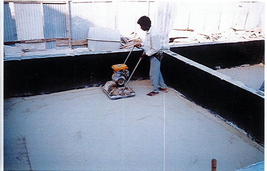
دك الفراغات والأرضيات بعد إعادة ملئها بالمواد المناسبة
