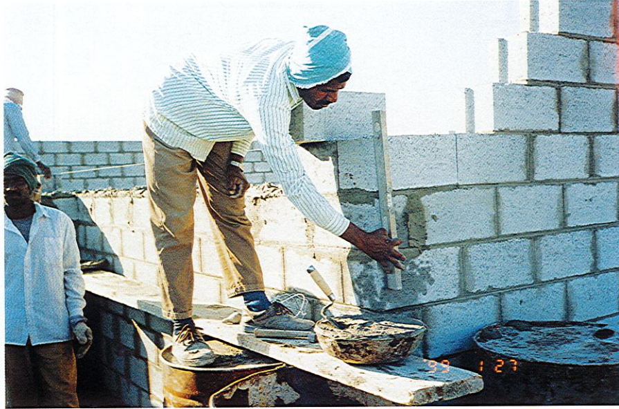
أعمال صف ورص الطابوق
