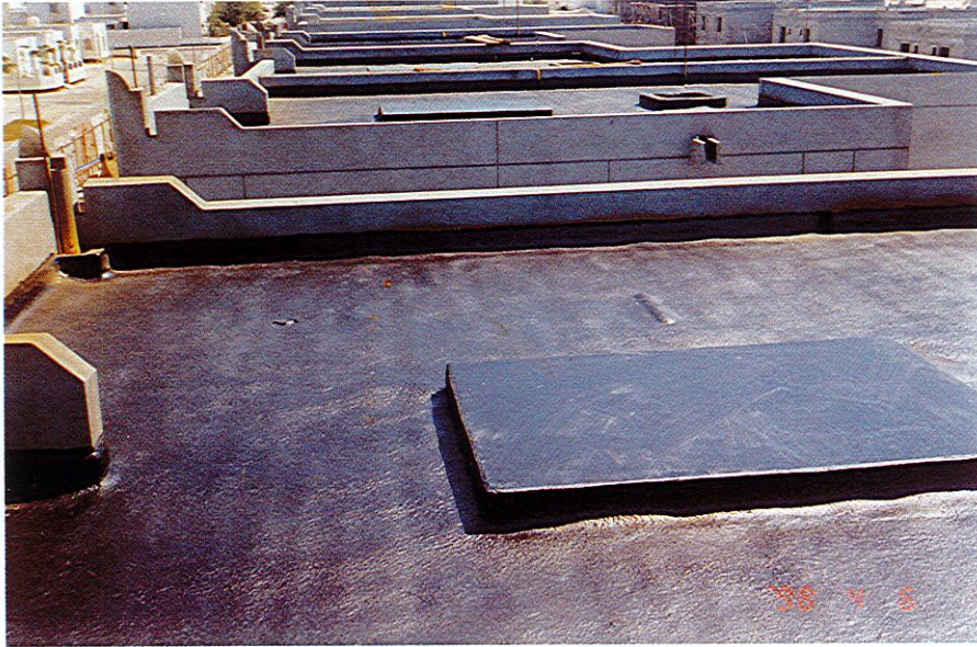
وضع المواد العازلة على الأسطح وتهيئة أماكن خزانات المياه
