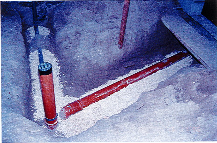
وضع أنابيب الصرف الصحي
