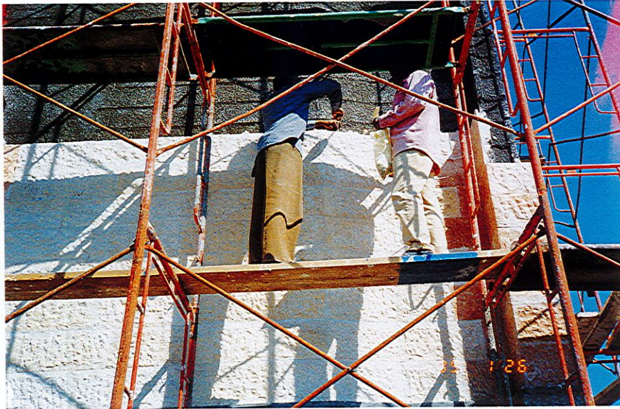
عملية تغطية الجدران بالحجر الصناعي
