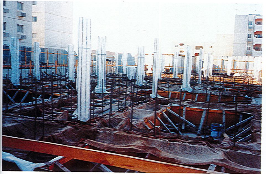
إنضاج الخرسانة بعد صبها وحماية حديد التسليح المكشوف
