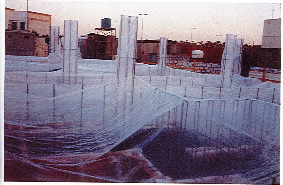
حماية حديد التسليح قبل صب الخرسانة
