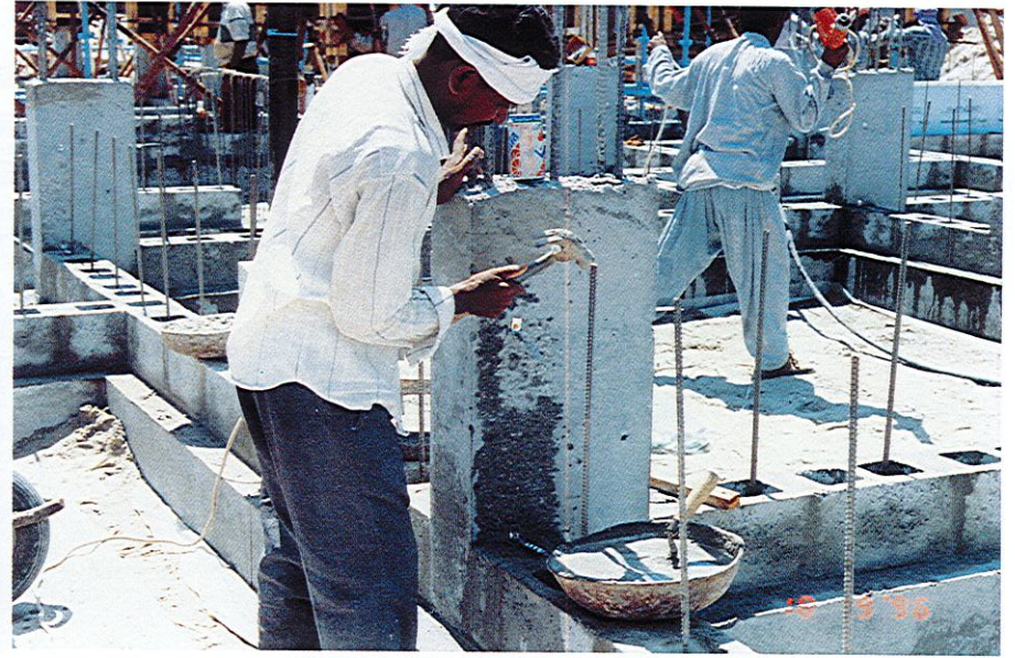
تهيئة الأعمدة لإستقبال أعمال الطابوق المجاورة
