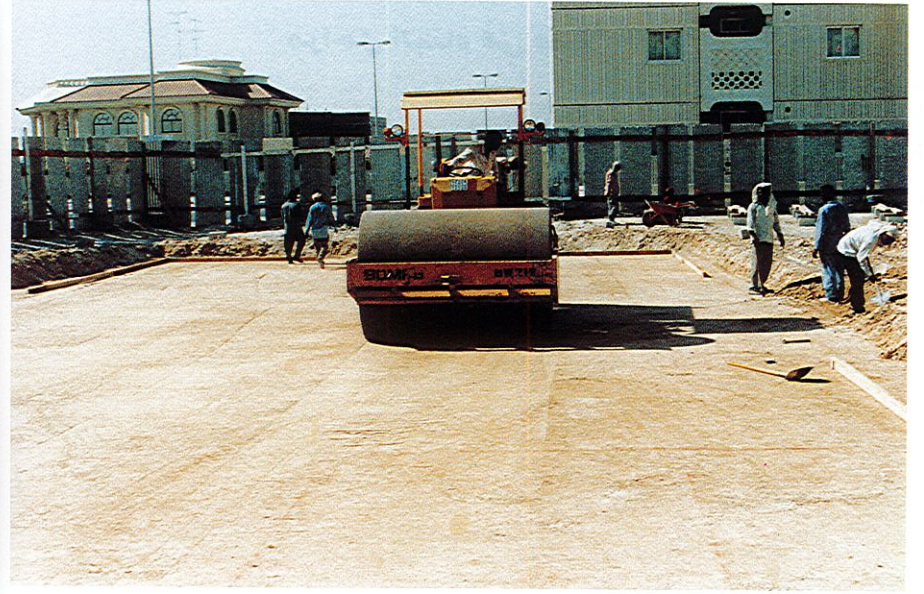
دك أرضية الموقع بعد إعادة ملئها بالتربة المناسبة
