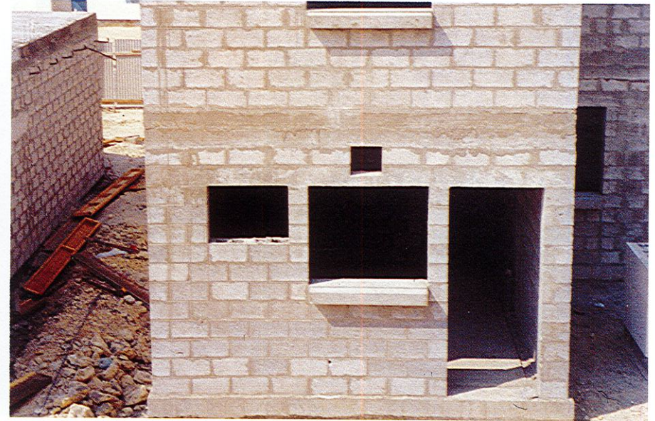
أعمال الطابوق والخرسانة بشكل عام قبل البدء بعملية المساح
