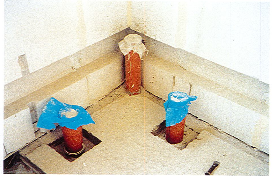
تركيب أنابيب الصرف الصحي
