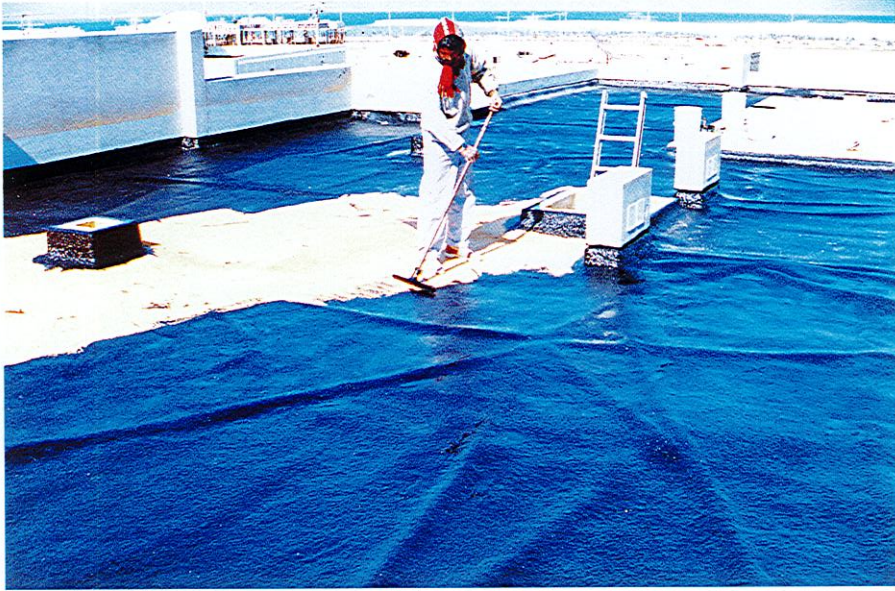
وضع المواد العازلة لحماية الأسطح
