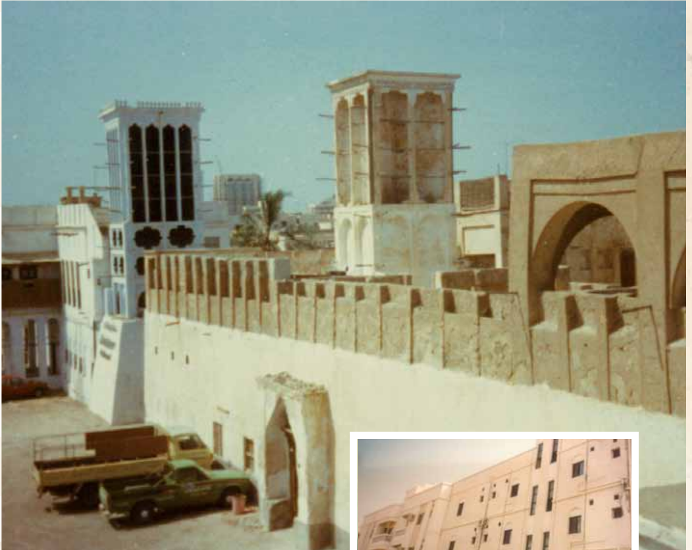
البناية قبل التحديث
