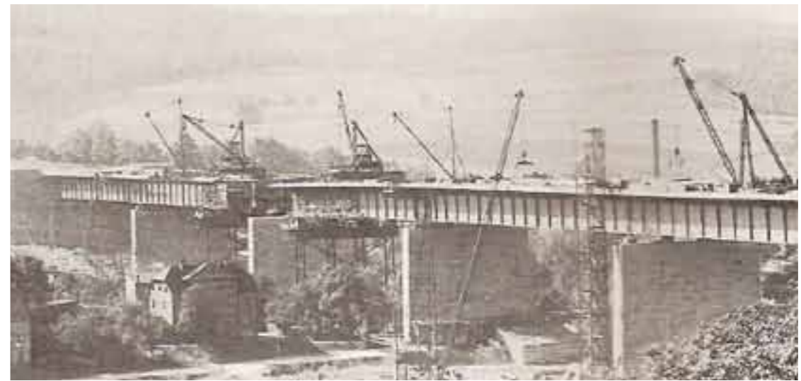
أثناء بناء الجسر القديم عام 1937
